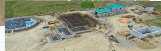
Planta de tratamiento Distrito 13 El Alto Avance 32,61 %
